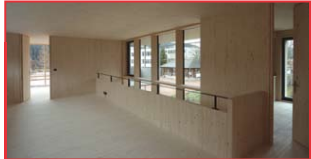
Holz dominiert: Die Blockholzplatten des Elementbaus sind unverputzt und bilden die Wandoberfläche. Raumhohe Türen verbessern die Wärmezirkulation im Haus.
