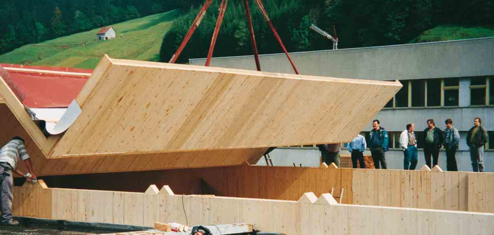
Hallen-Faltwerkdach aus 60 mm starken Blockholzplatten (Spannweite 10 m).
