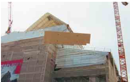
Umbau Bundeshaus Bern. Blockholzelemente für Dachkonstruktion über Ständeratssaal.
