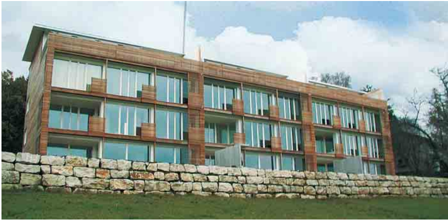
Nullenergie-Mehrfamilienhaus «SUNNY WOODS», Zürich (europ. Solarpreis 2003). Gesamte Tragkonstruktion aus Blockholz.
