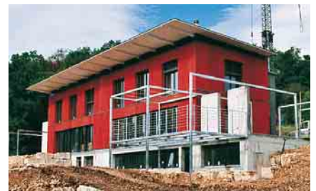
Blockholzgebäude mit hinterlüfteter Fassade.
