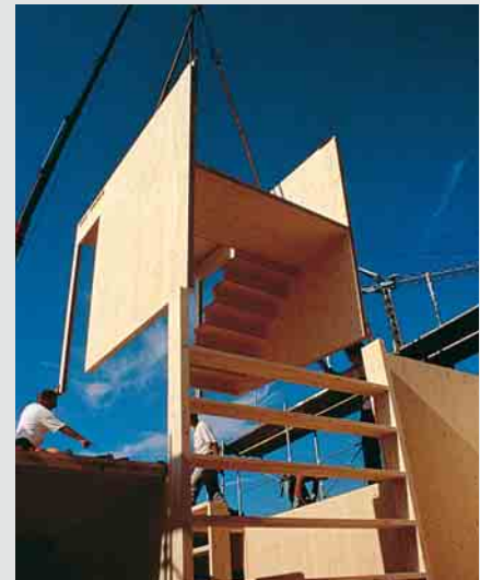
Vorfabriziertes Treppenmodul bei Montage
