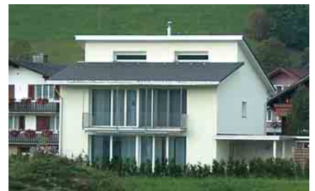
Blockholzgebäude mit verputzter Kompaktfassade.
