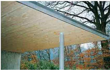
Zweiseitig auskragende Flachdecke.
