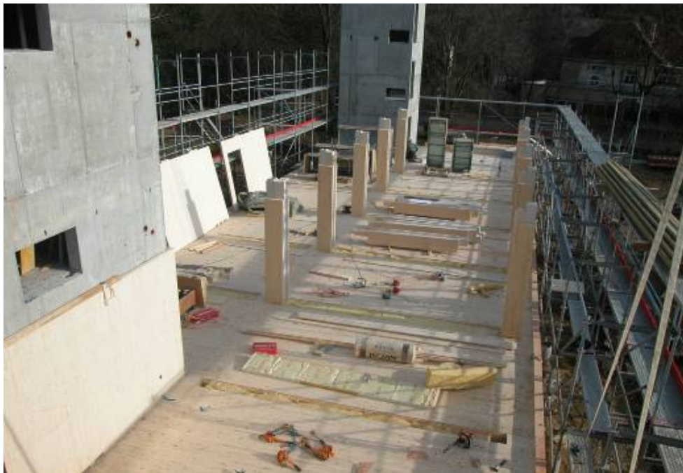
Montage des Holzbaus
