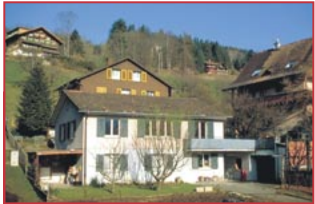
Das Gebäude mit Baujahr 1961 vor der Erneuerung.
